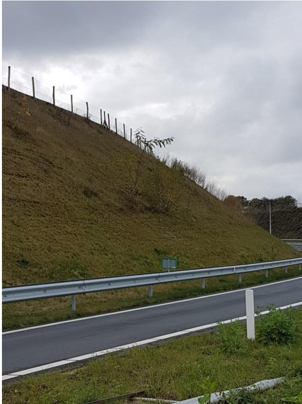
Foto 50 Rechts tussen Brunsummerweg en N276. Vanaf verharding beperkt maaibaar = in 1e instantie maaien zover mogelijk vanaf rijbaan / berm , met gepast materieel. Wel bovenop vlakke berm maaien tot en met faunaraster. Wat niet bereikbaar is niet maaien, houtopslag dient in 2020 en 2022 te worden verwijderd op die locaties waar gras is blijven staan.
