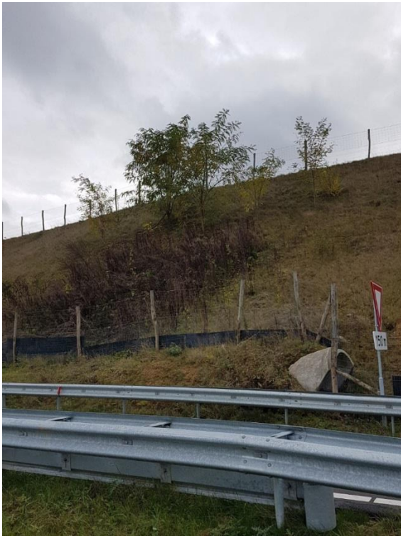
Foto 52 Rechts tussen Brunsummerweg en N276. Achterstallig onderhoud (middenstrook moeilijk of niet te maaien) in 1e instantie maaien zover mogelijk vanaf rijbaan / berm , met gepast materiaal. Wel bovenop vlakke berm maaien tot en met faunaraster. Wat niet bereikbaar is niet maaien, houtopslag dient in 2020 en 2022 te worden verwijderd op die locaties waar gras is blijven staan.
